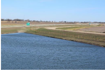
CSAH 1 On-Ramp to Hwy 14
