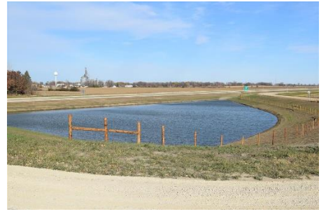
CSAH 1 On-Ramp to Hwy 14
