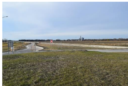
Hwy 14 Exit Ramp to CSAH 3
