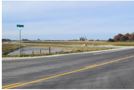
Hwy 14 Exit Ramp to CSAH 1
