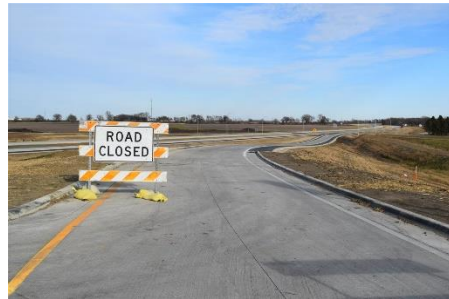
CSAH 3 On-Ramp to Hwy 14
